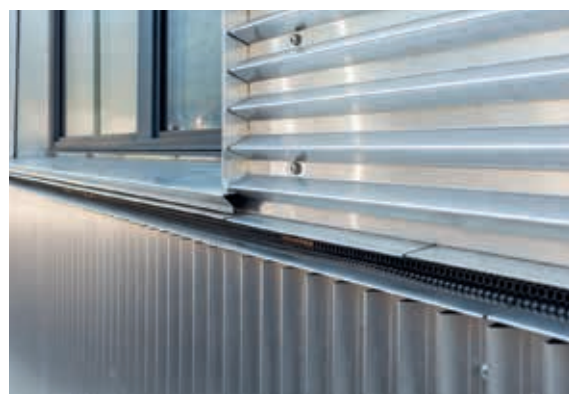
Fensterbank und Leibungen aus Aluminium, 1 mm dick.
