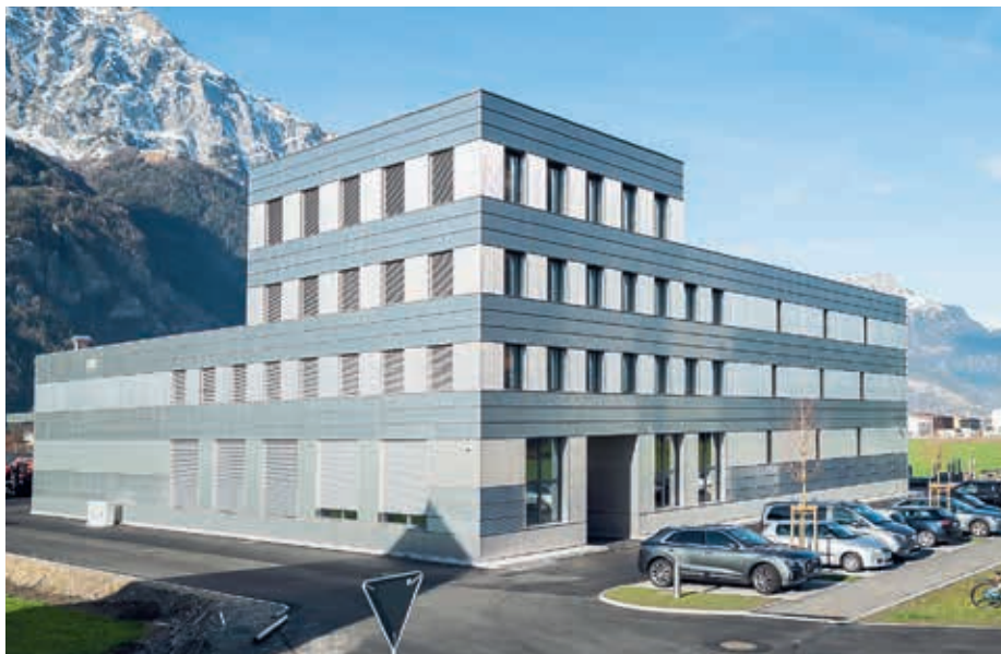
Das Kompetenzzentrum der Kässbohrer Schweiz AG ist der erste Betrieb auf dem Industrieareal «Werkmatt» in Uri und somit Teil des Entwicklungsschwerpunktes «Urner Talboden».
