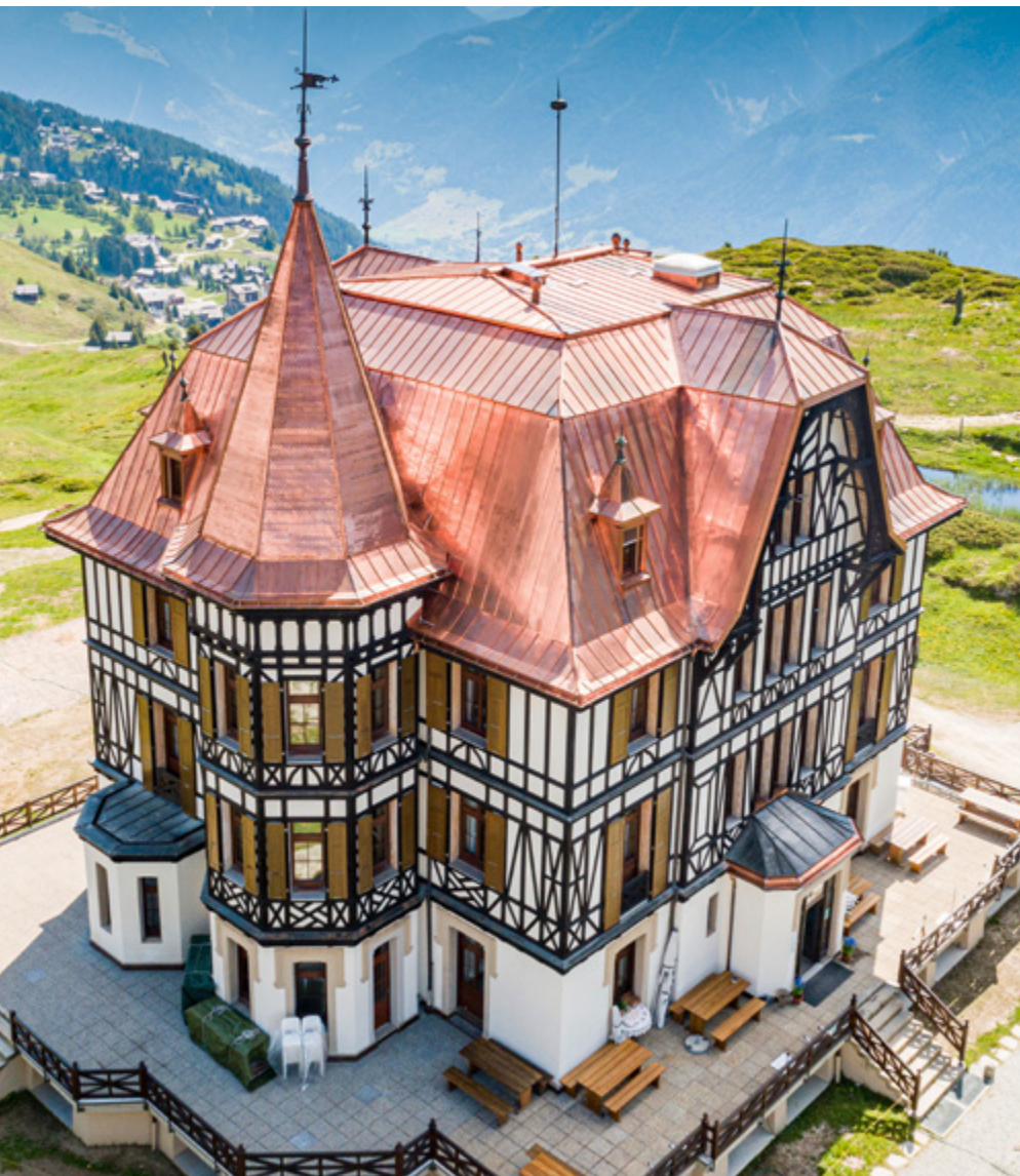
Das glänzende, neue Dach der Villa Cassel aus Kupfer, ein Bild wie im Märchen.
